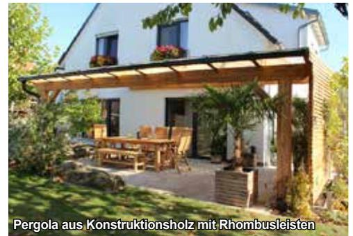
Pergola aus Konstruktionsholz mit Rhombusleisten
