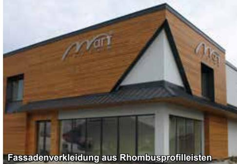
Fassadenverkleidung aus Rhombusprofileleisten
