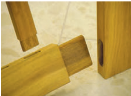
8. Alle Torverbindungen werden solide gezapft.
