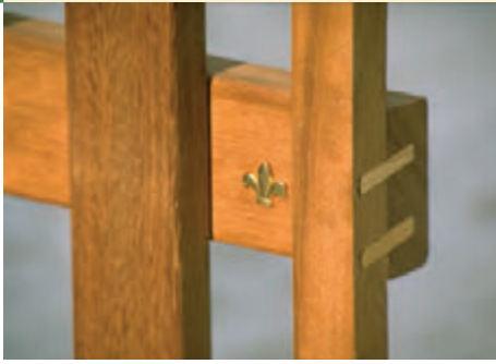
1. Verdeckt gedübelte Zaunelemente sind Standard
