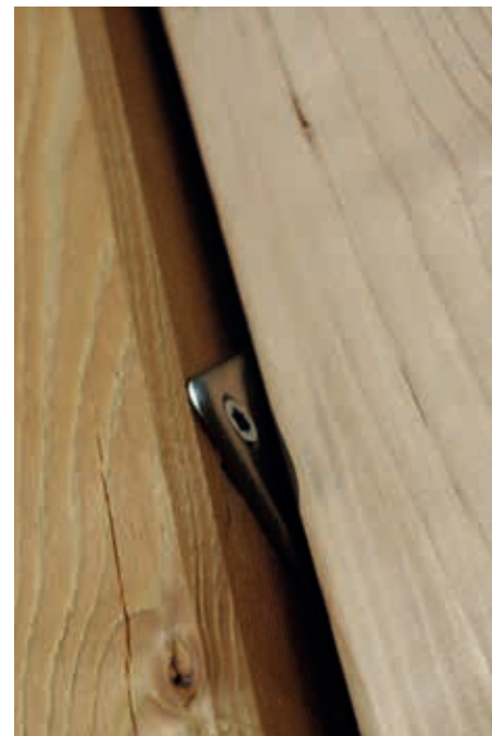
Vorbereitet für Befestigungssystem JodaFix®
