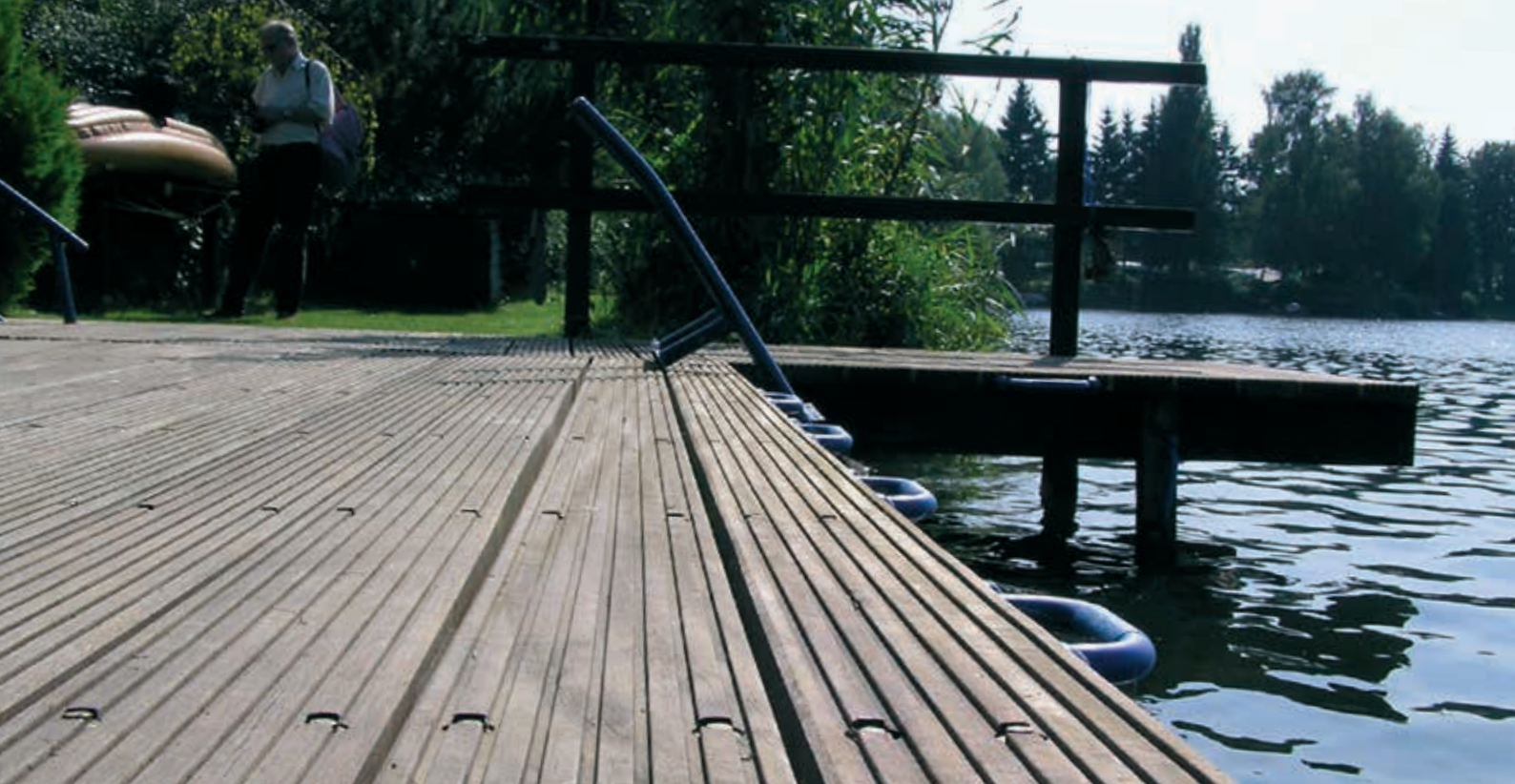
Unterkonstruktion im Wasser: Anwendungsbeispiel für Bongossi-Kantholz
