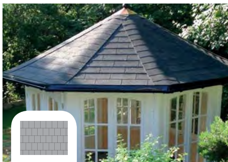
Fertig beschindelt bis 350 cm Durchmesser
