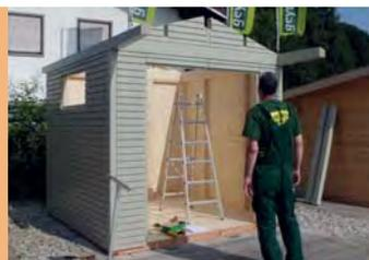
Einsetzen der fertig montierten Wand- und Giebelelemente
